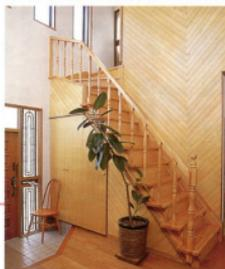
▲玄関のフロアをTIPを生かした斜め張りに、欄の柱目の合板を使用。
