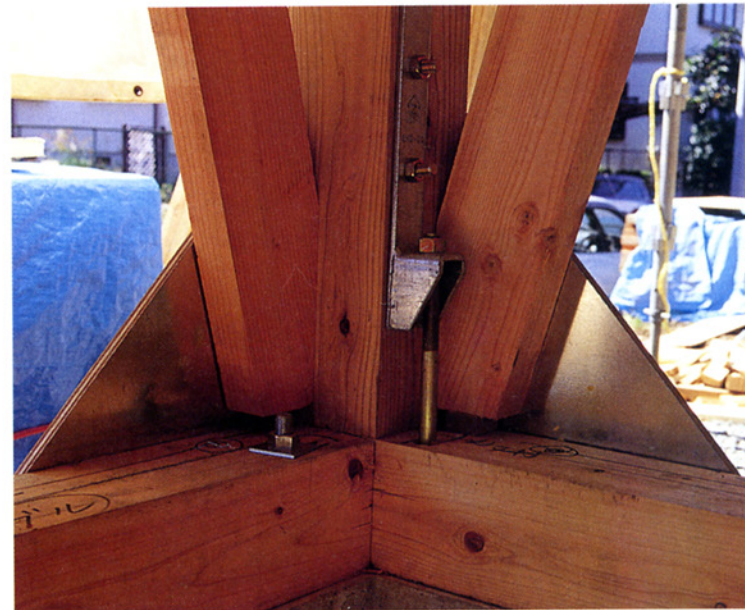
土台と筋交いの接合部。2cmのすき間を設けるため、施工では木片を定規代わりに使っている
