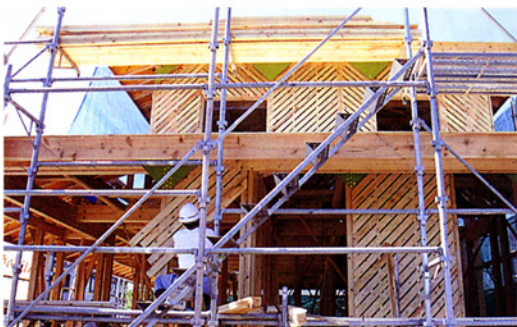
斜めに張るため、上下の移動が多くなる。横に張る場合に比べて、大工の手間は1.5倍程度になるという
