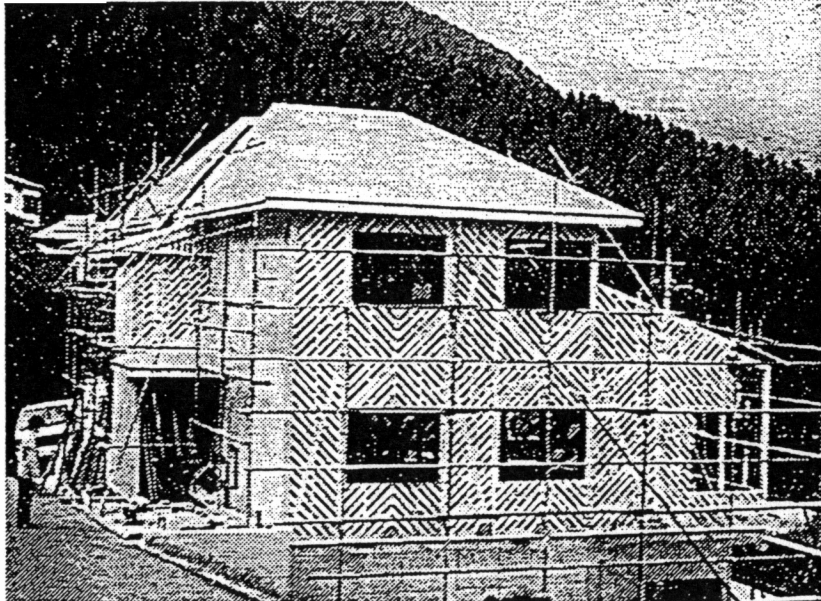
TIP構法を使って建築中の熱海市内の民家
